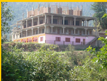
Construction d'un monastère-Ecole en Inde du Nord
